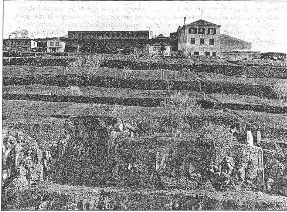
Hospital de Isolamento de Câmara de Lobos, 1910 (vista pelas traseiras do edifício, à parir do Servado do Mar)
